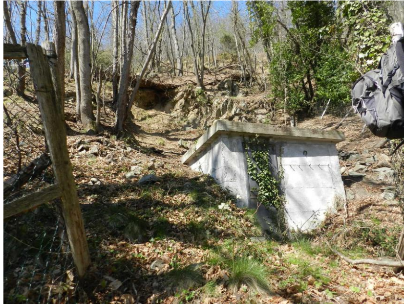
Foto n.2 – sorgente Portiglione che fuoriesce dalla roccia
